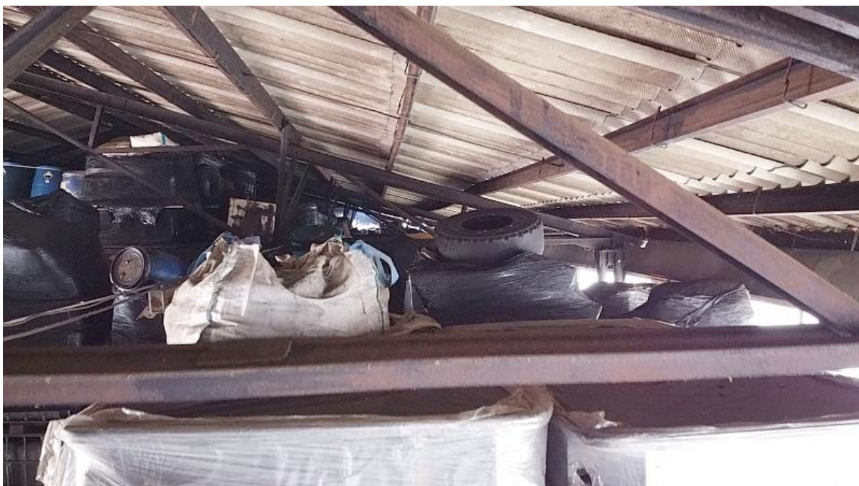
Fot. 3 Sposób gromadzenia odpadów w strefie 2 (widoczna największa ilość warstw w części centralnej)
